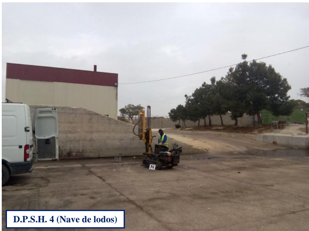
Sondeo 4 (Nave de lodos)
