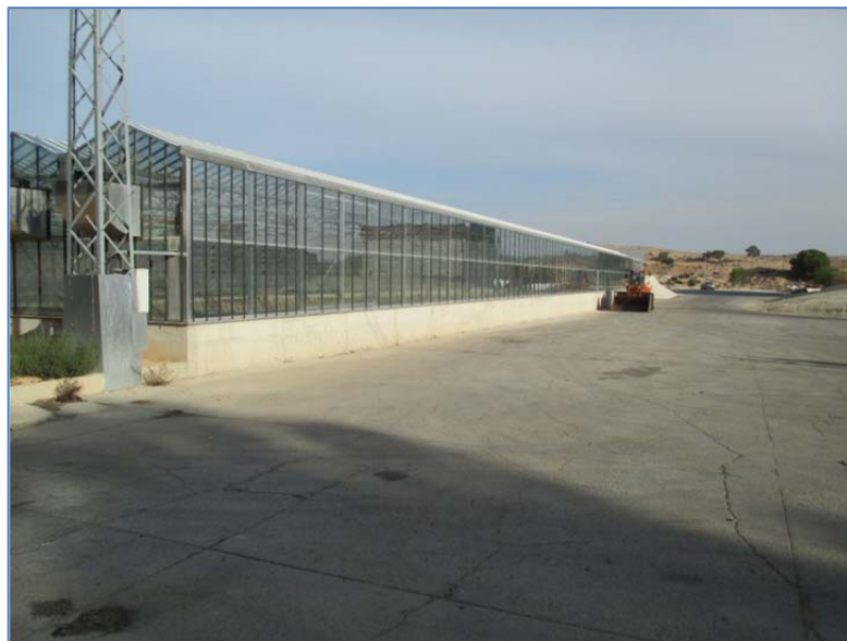
FIGURA 7-2. VISTA DE LA UBICACIÓN DE LA NUEVA PLANTA DE SECADO DE LODOS
